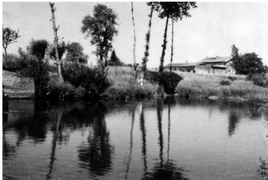
TaSol et Robert devant le déversoir ; à gauche, un des murs du barrage ; au fond, les bâtiments du moulin
